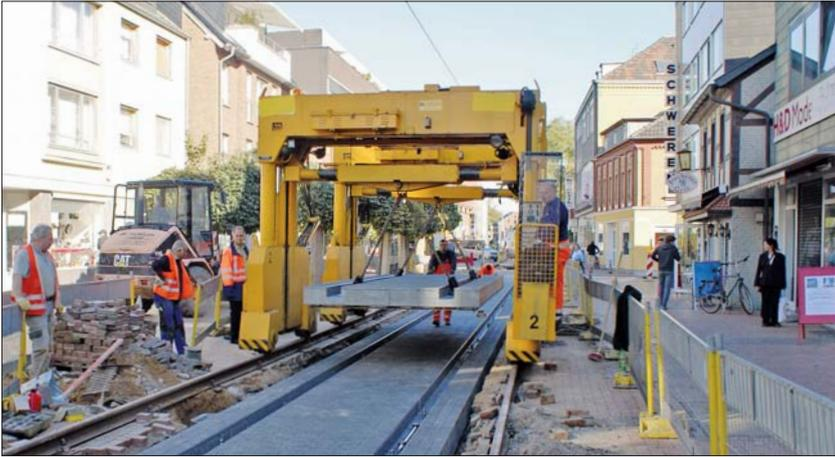
Längstransport und Verlegen der Max-Bögl-Gleistragplatten mit Portalcrane „Donelli“
